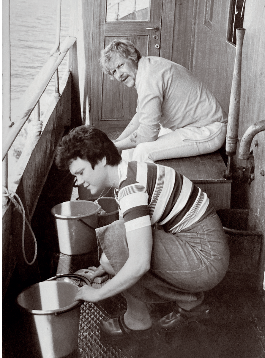
Keittiöväki käytti hyväkseen ulkotilojakin välikannella, jos työt sitä vaativat. KUVA: KAISU TASKINEN.
